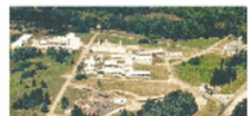
Vista aérea del Centro Atómico Ezeiza (CAE), donde funcionan un reactor y el ciclotrón productores de radioisótopos para uso médico.
